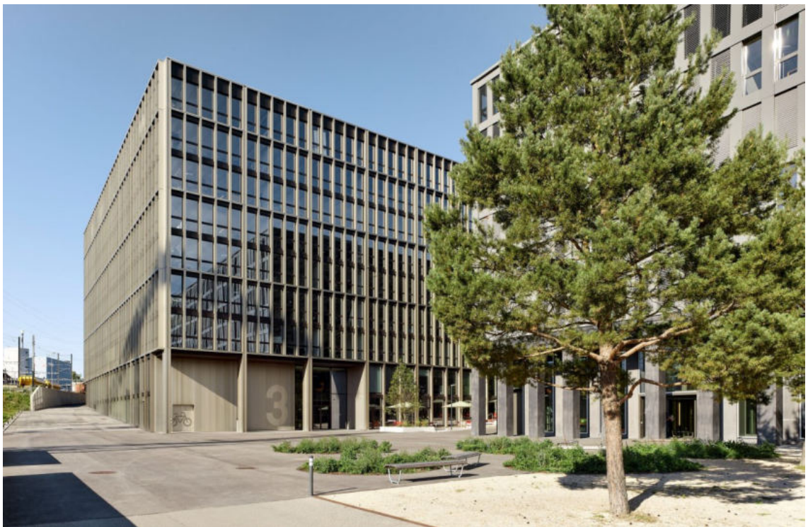
Biodiversitätsfläche Eichenweg 1 und Eingangssituation Nordfassade Eichenweg 3. © Rolf Siegenthaler
