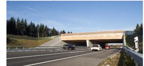
Neuenkirch (CH) 2021, zwei Einfeldträger aus Holz; Spannweite 2 x 17.50 m; Breite 50 m; 2500 m<sup>3</sup> Fichte (Foto n'H)
