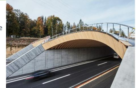
Suhr, Rynetal (CH) 2020, symmetrischer Doppelbogen aus Holz, Spannweite 2 x 17.4 m; Breite 54 m; 640 m<sup>3</sup> Fichte BSH (Foto Timbatec)
