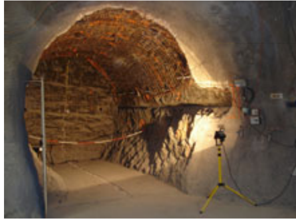
Figur 5: Blick in den Teststollen des EZ-B Experimentes (Länge 6.5 m, Durchmesser 3.8 m). Deutlich erkennbar ist die Spur der vor dem Ausbruch des Teststollens abgeteuften horizontalen Bohrung auf der rechten Seite des Bildes, welche zusammen mit einer weiteren Bohrung zur seismischen Charakterisierung des Gebirges diente (Quelle: HSK).
