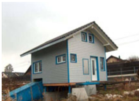
Figur 7: Wasserkraftschnecke mit dazugehörigem Gebäude. (Bild: T. Köhli).
