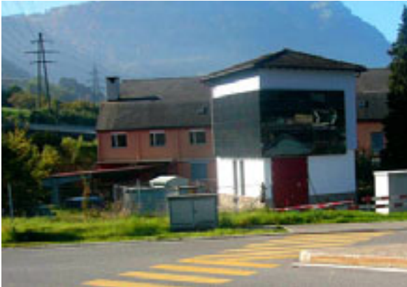
Figur 7: Fassadenintegration mit Dünnschichtmodulen (Bildquelle: Zagsolar).
