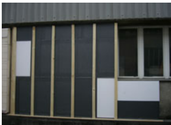
Figur 7: Ansicht der Testmontage des Distanzschrauben-Systems, vor der Montage der Aussenschale (FHNW)
