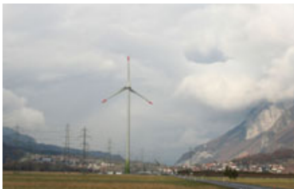
Figur 9: 2 MW-Anlage Enercon E70 in Collonges, Jahresproduktion 2006 über 4 GWh. Quelle: Rhoneole.
