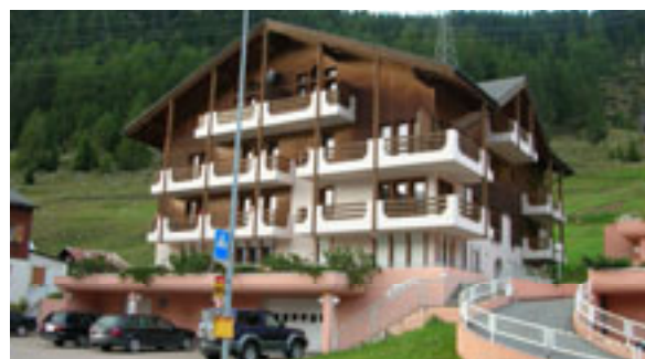
Figur 7: Haus Kristall in Oberwald, das mit einer Wärmepumpe mit Abwasserwärme aus dem Furka-Tunnel beheizt wird.
