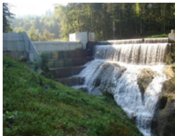
Figur 8: Fertiggestelltes Wasserkraftwerk Buchholz. (Bild: Entegra AG).
