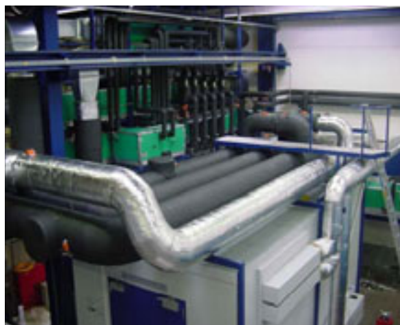
Figur 12: Ansicht Prüfstand an der HTA Luzern.
