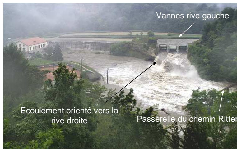
Figure 6 : Photographie depuis l'aval du barrage de la Maigrauge le 22 août 2005 [4]
