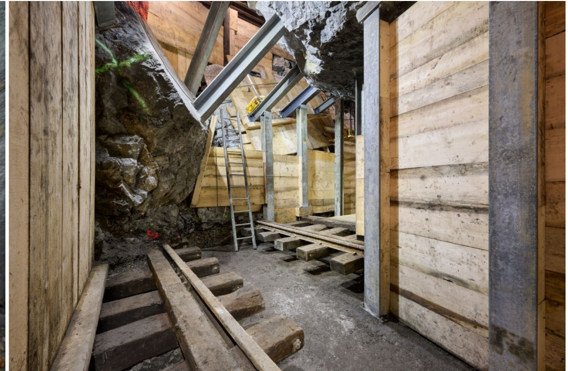
Vorstoss bis Bahngleise, umfangreiche Steinschlag-Sicherungen
