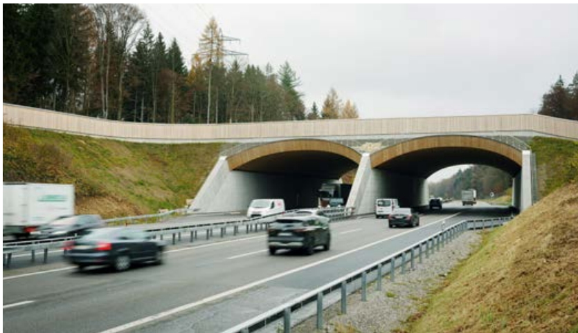
Wildtierüberführung mit Bestandteilen aus Holz über die Autobahn A1 im Gebiet Rynetel zwischen Suhr und Gränichen im Kanton Aargau.
