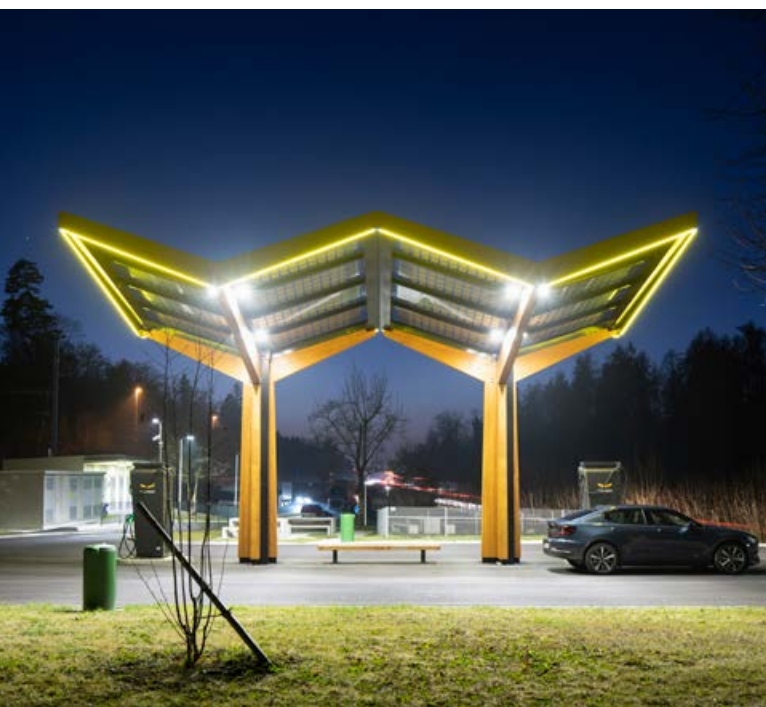
Das ASTRA setzt sich aktiv für energieeffizientere Fahrzeuge auf den Schweizer Strassen ein. Ein wichtiges Anliegen ist der Aufbau eines Schnellladenetzes entlang der Nationalstrasse. Das Bild zeigt eine Schnellladestation mit Solardach auf dem Rastplatz auf der A1 bei Lenzburg im Kanton Aargau.
