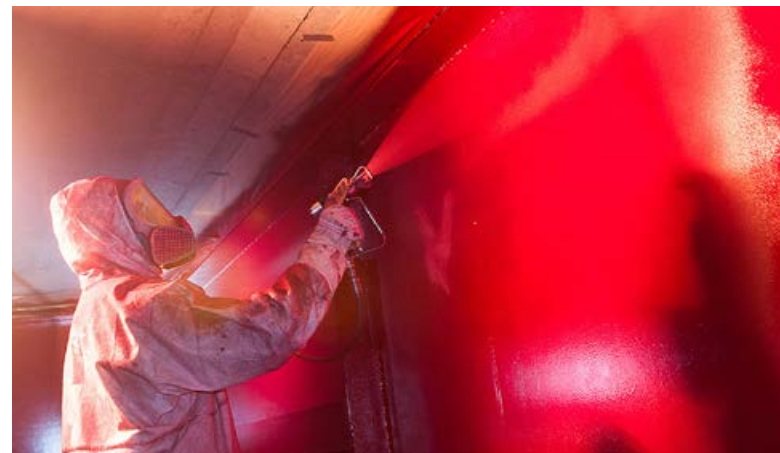
Unter der Schutzhülle wird Korrosionsschutzfarbe aufgetragen.
