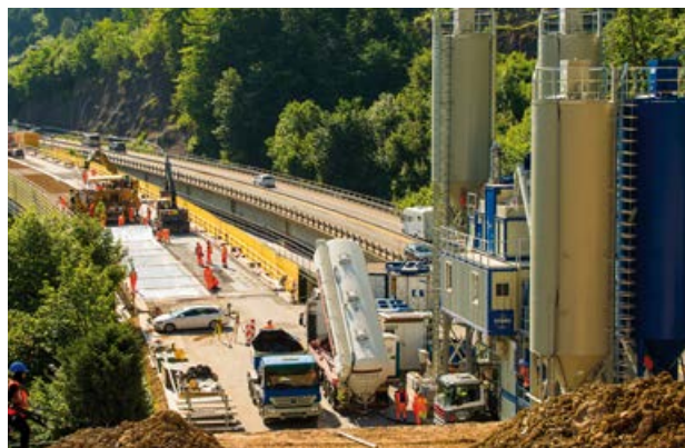
Instandsetzung nach rund 45 Jahren: Sanierung der drei Brücken Boli, Mettlen und Linden bei Küssnacht (Kanton Schwyz)
