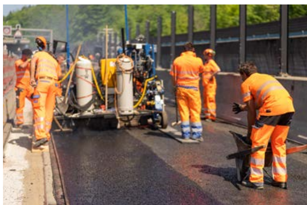
Instandsetzungsarbeiten bei der Stadtautobahn St. Gallen
