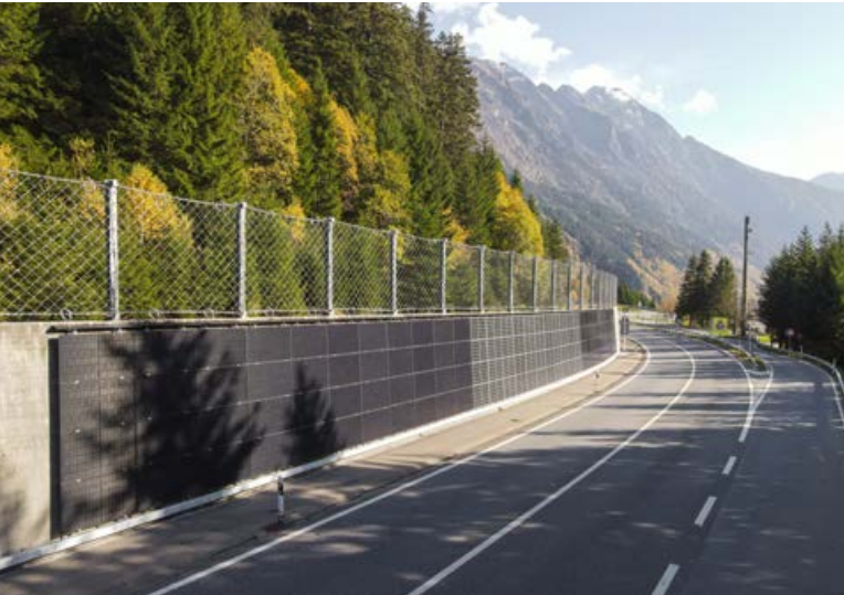
Versuchsanlage für Stromproduktion an der A13 auf dem Bernardino im Kanton Graubünden
