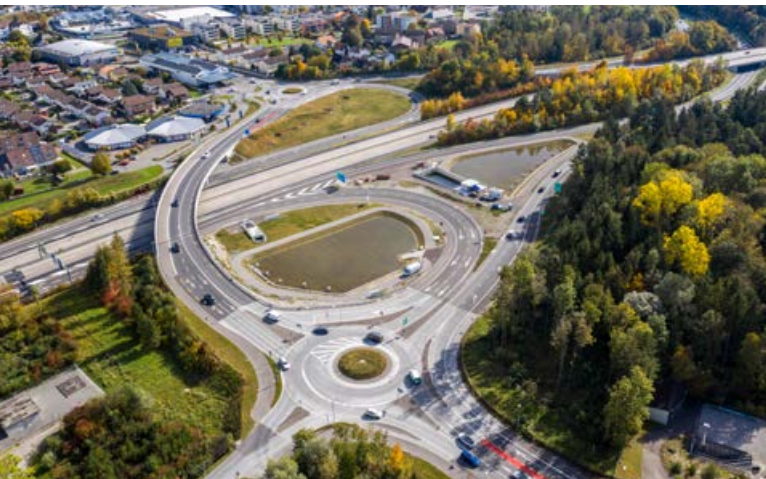
Strassenabwasser-Behandlungsanlage beim Anschluss Thun Nord im Kanton Bern
