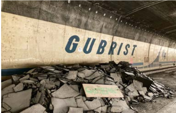
Das ASTRA entsorgt altes Baumaterial fachgerecht.
