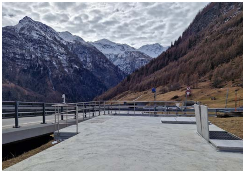
Rückhaltebecken Krummenbach auf der A9 am Simplonpass
