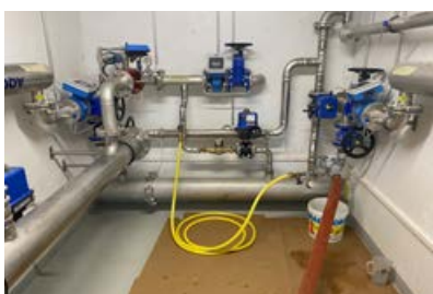
Projekt A9 Vennes-Chexbres: Das ASTRA kontrolliert die Qualität des Wassers, das aus der Schutzzone kommt.
