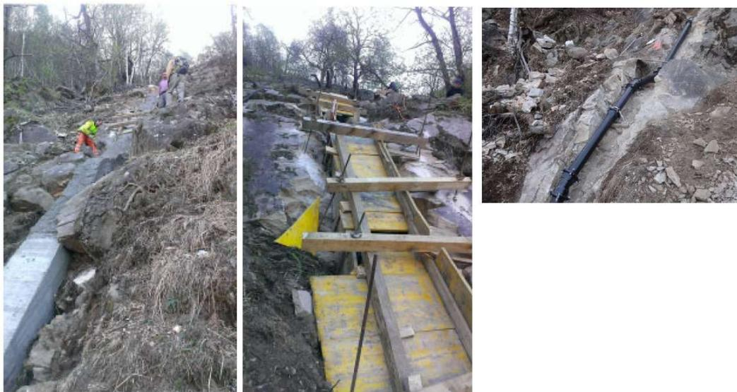
*Figura 11: Esempio fase di costruzione di bauletto in un contesto di pendio molto ripido (>30%) e substrato roccioso con debole strato di copertura (qui NON alta tensione ma acqua potabile diametro ~50 cm)*
