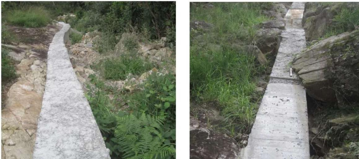
*Figura 12: Esempio di bauletto terminato in un contesto di pendio molto ripido (>30%) e substrato roccioso con debole strato di copertura (qui NON alta tensione ma acqua potabile diametro ~50 cm)*
