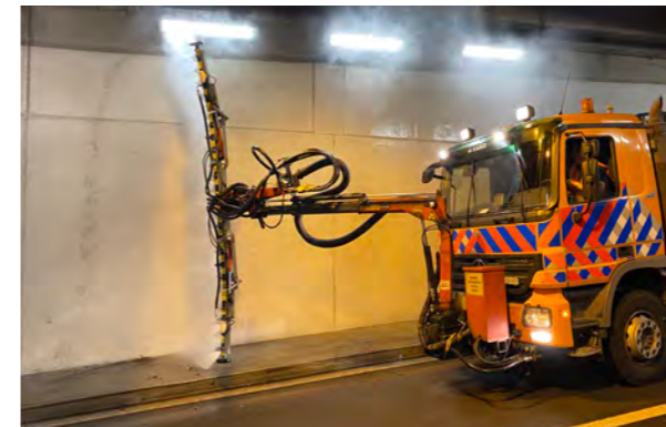
Nettoyage de tunnels
