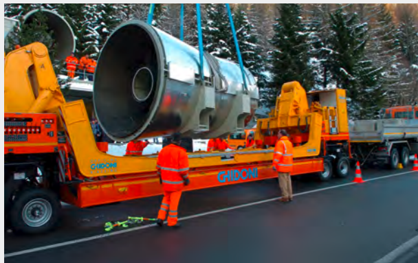
Maintenance des ventilateurs
