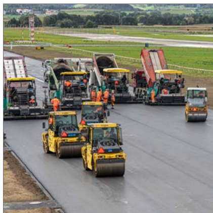
Risanamento della pista di decollo e di atterraggio
