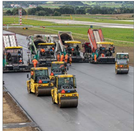
Sanierung der Start- und Landebahn
