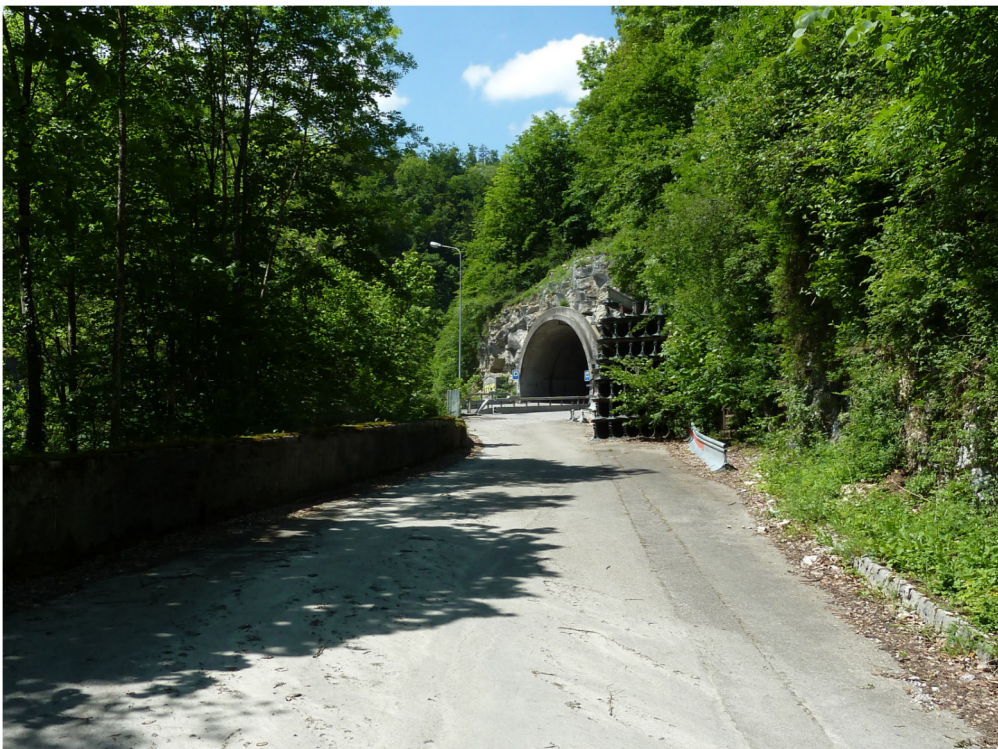
Oggi: transito attraverso la galleria
