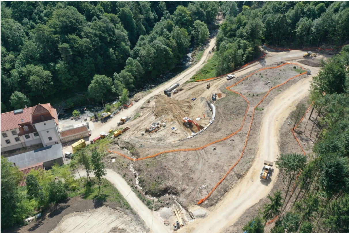
Il nuovo tracciato, ancora in fase di cantiere
