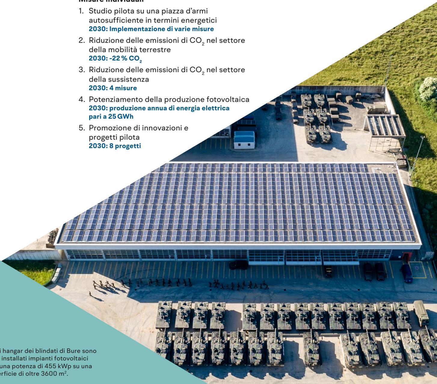
Sugli hangar dei blindati di Bure sono stati installati impianti fotovoltaici con una potenza di 455 kWp su una superficie di oltre 3600 m<sup>2</sup>.
