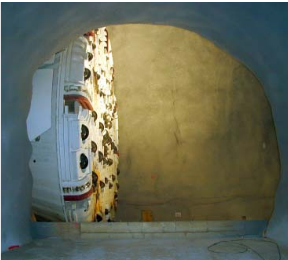
Achse Gotthard Amsteg: Tunnel- bohrmaschine Oströhre
