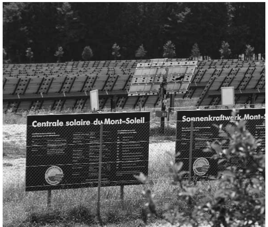
Centrale solaire du Mont-Soleil
