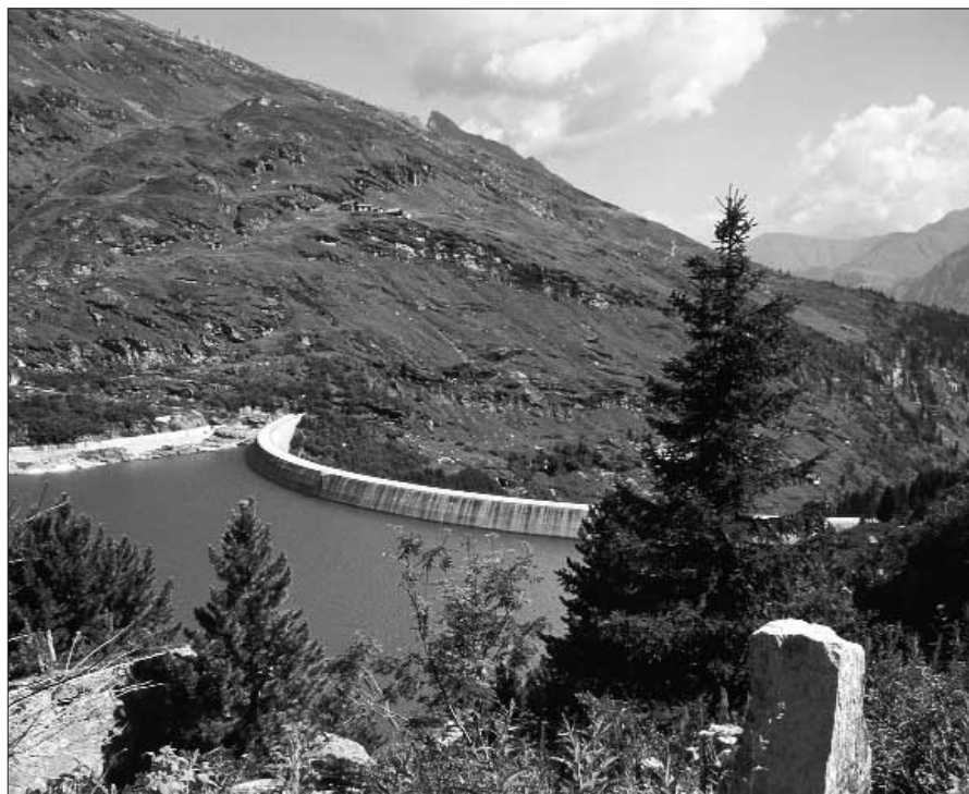
Die Schweizer Alpen – das Wasserschloss Europas – sind dank ihrem Relief prädestiniert für Speicherkraftwerke.
