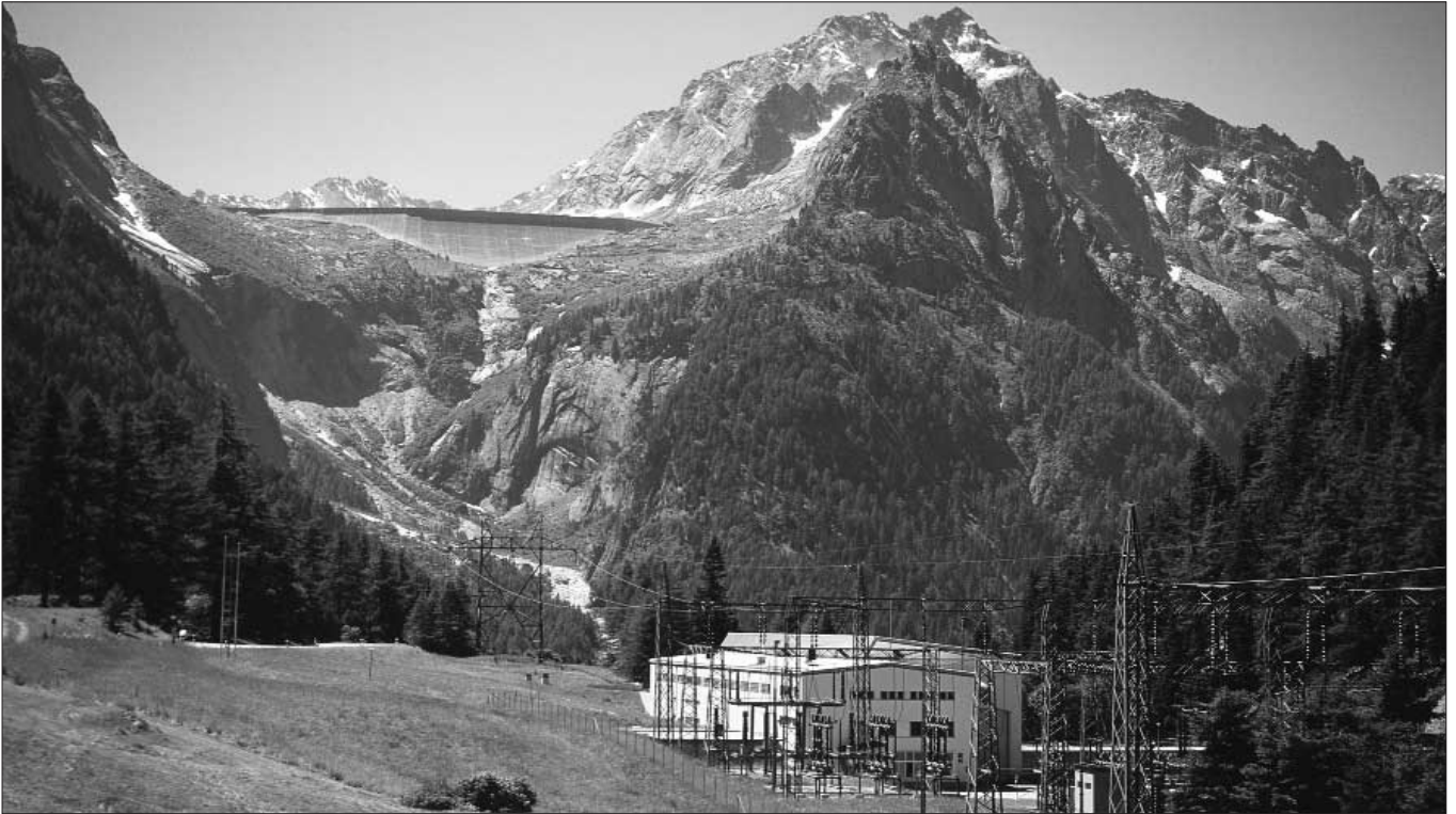
Albiga-Kraftwerk im Bergell – im Besitz der Stadt Zürich.
