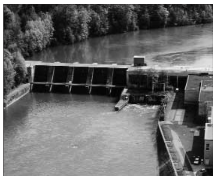
Die Wasserkraft ist mit rund 60% Produktionsanteil Hauptpfeiler der schweizerischen Stromversorgung. Flusskraftwerk Bremgarten-Zufikon (Foto z.V.g.).
