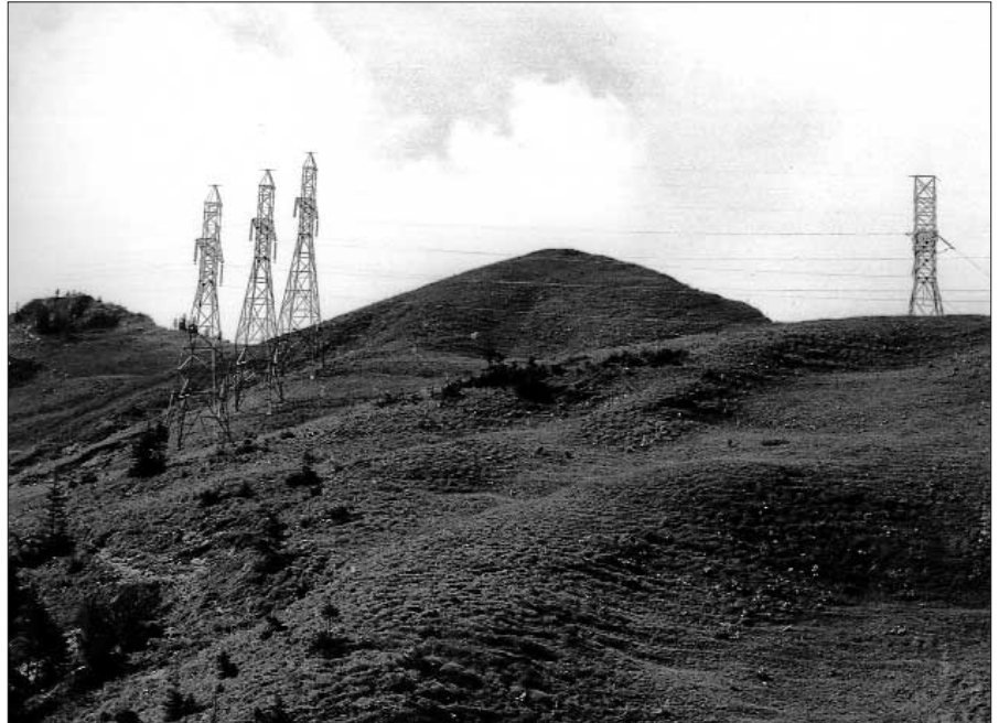
Die Übertragungsleitungen als grossmassstäbliche Elemente überformen das kleinmassstäbliche Umfeld (Foto: A. Erni, EBP).
