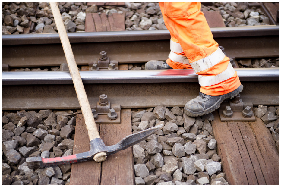
Arbeiten auf dem Gleis erfordern besondere Aufmerksamkeit und gute Organisation.
