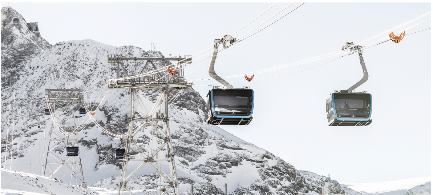
Seilbahnen sind für windige Wetterverhältnisse vorbereitet.
