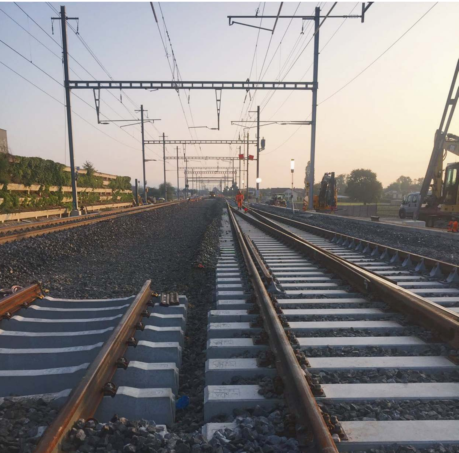
AS25, Bau Überholgleis Coppet-Founex abends.
