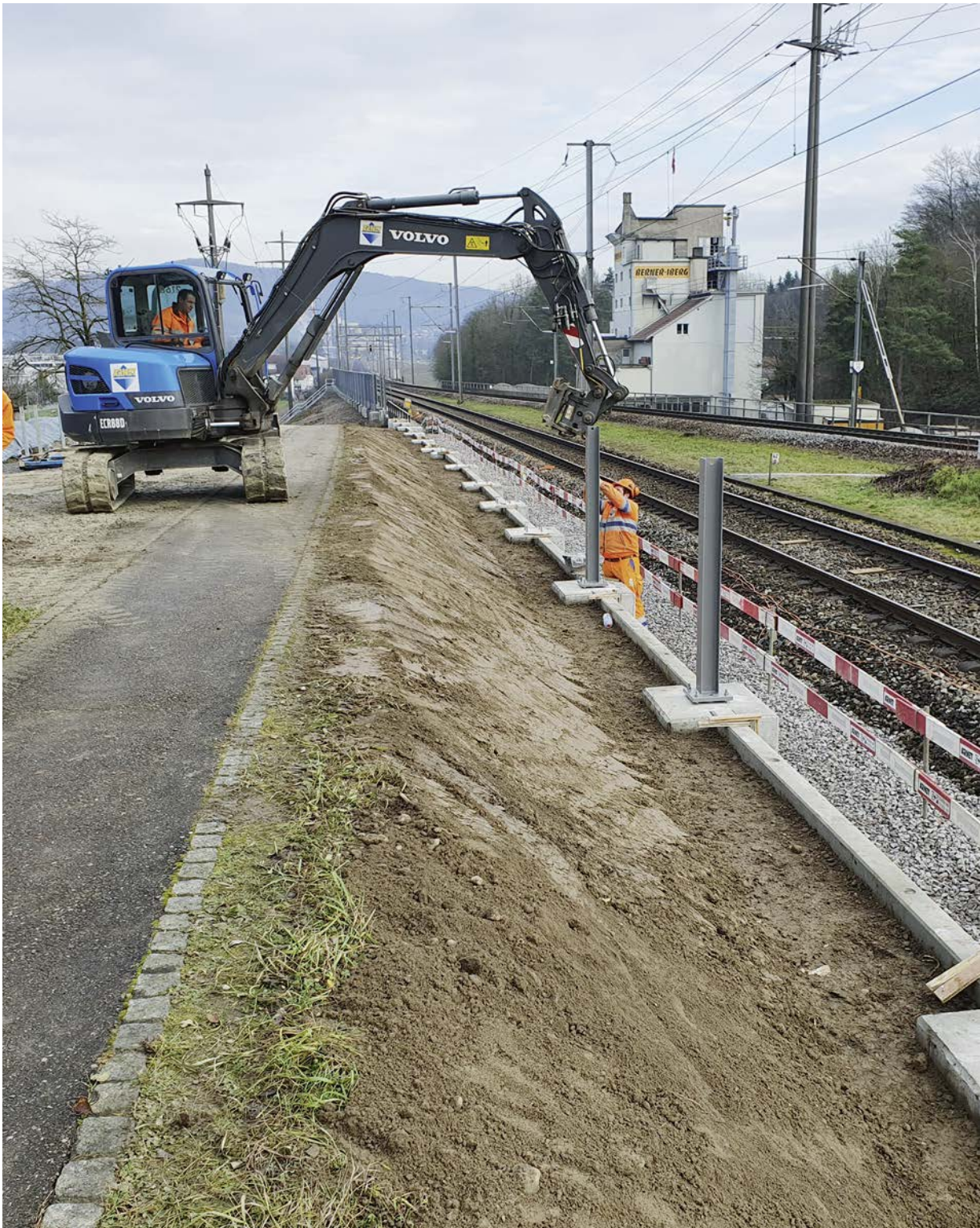
Kleinbagger in Rapperswil.
