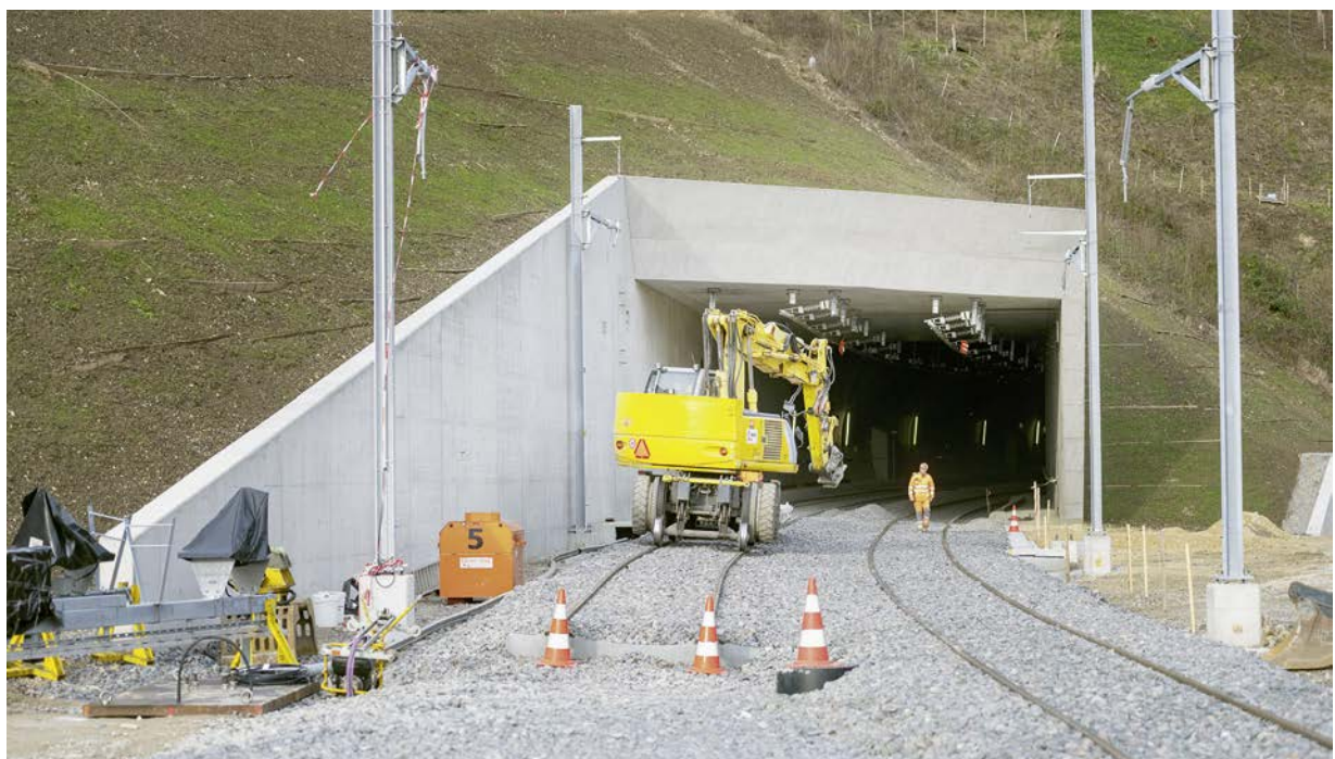
4mK Bötzing, gleisgebundene Bauarbeiten im Tunnel.
