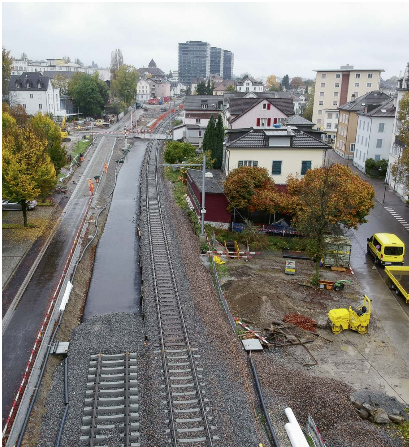
HGV-A, Doppelspurausbau Goldach–Rorschach Stadt.
