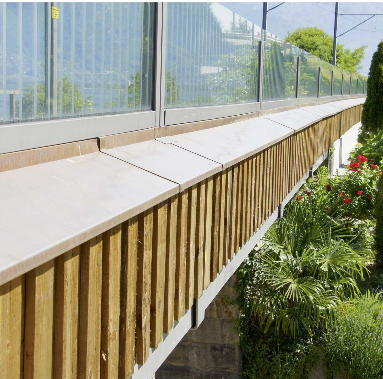
Lärmschutzwand San Nazarro.
