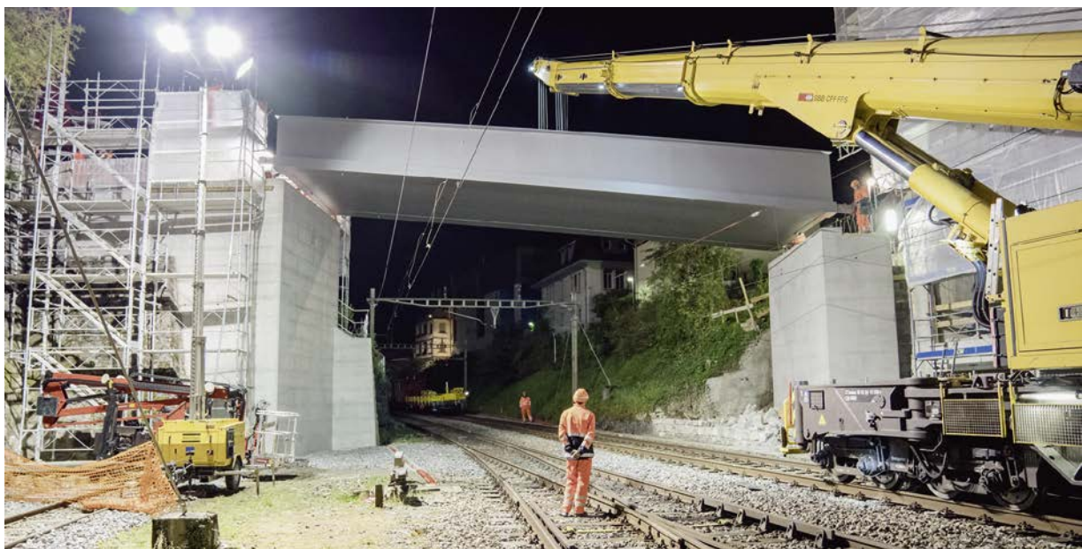
ZEB, Vevey-Leuk, Ausbau auf Doppelstockprofil.
