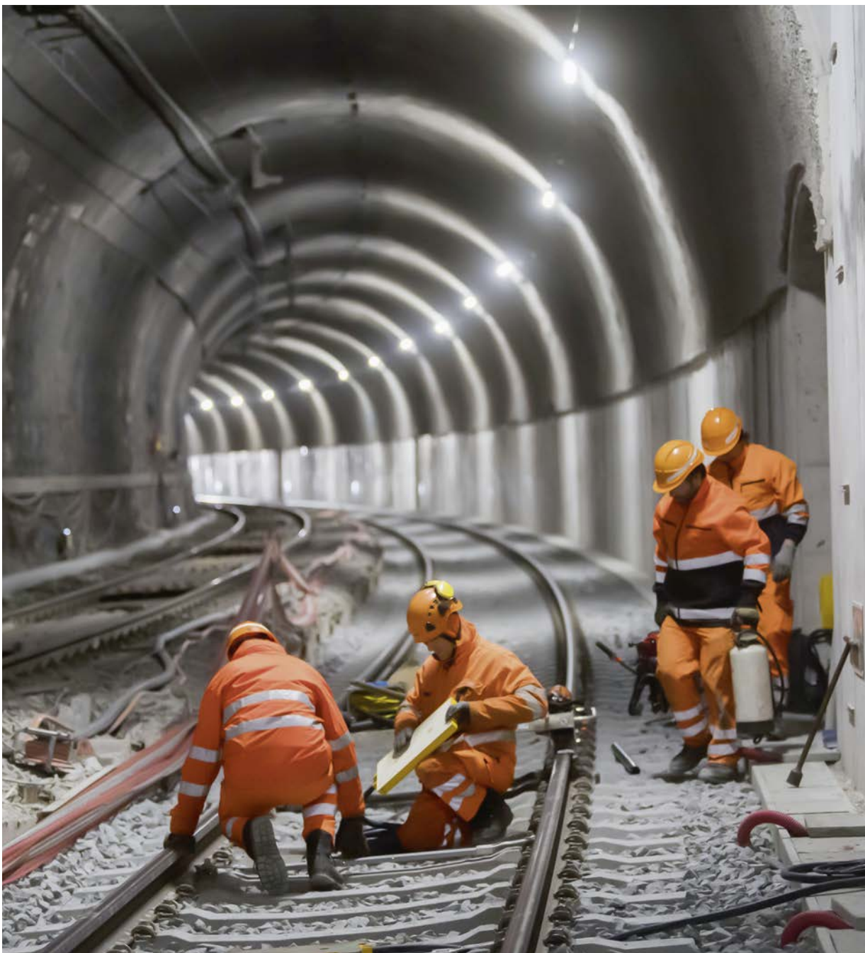
4-Meter-Korridor, Profilerweiterung Paradiso-Tunnel.
