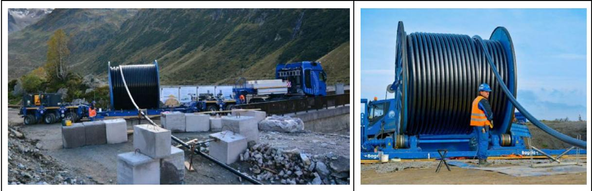
**Abbildung 10: Kabelverlegung ab Transportfahrzeug oder abgeladener Kabeltrommel (Quelle: Fa. Wassermann Kabeltechnik)**
