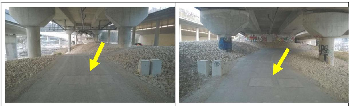
**Abbildung 6: Vorbereiteter 380/200 kV-Leitungszug Wollishofen-Uetlibergtunnel mit Dienststrasse und Muffenschacht unter einer der Brücken der Autobahnverzweigung Zürich Süd (Pfeile: Deckel der Muffenschächte)**
