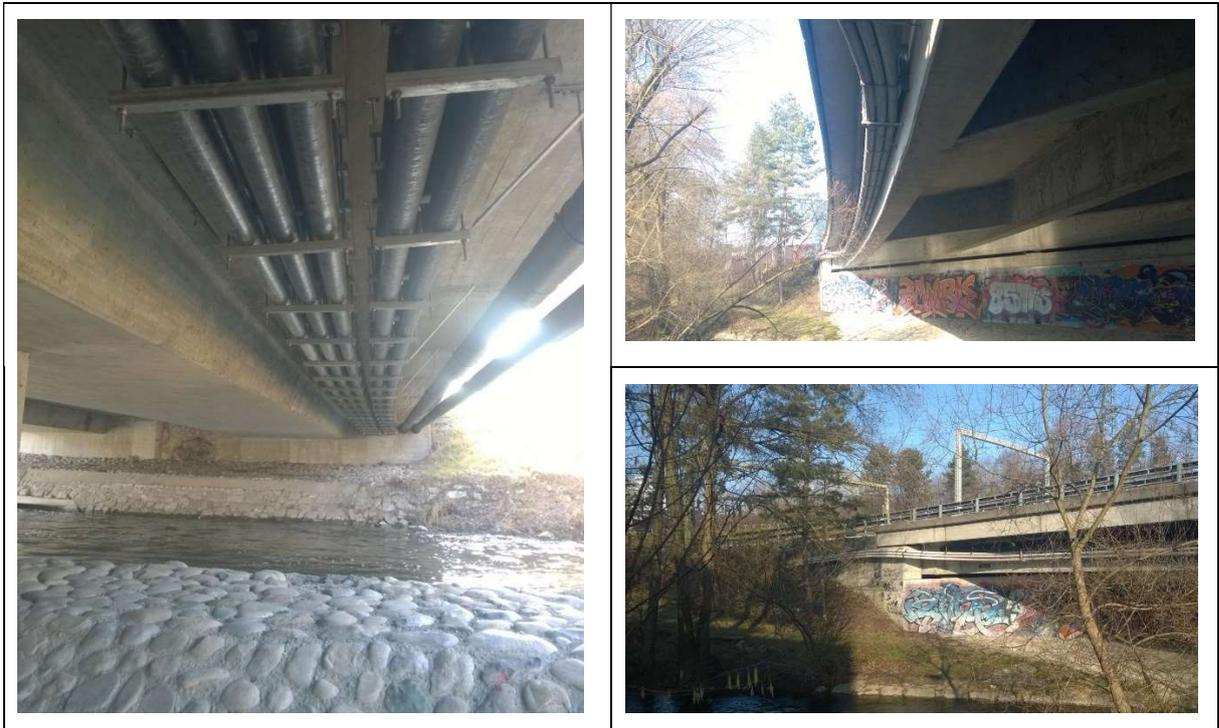
**Abbildung 5: Brücken mit angehängten Kabelleitungen tieferer Netzebenen oder mit Kabeln der Trägerinfrastruktur**
