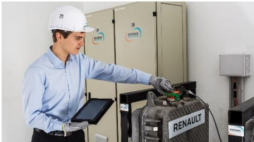
Das "Energy Local Storage Advanced System", Teil des Forschungs- und Innovationsprogramms der Europäischen Union "Horizon 2020", kommt in die Schweiz. In diesem Projekt werden gebrauchte Batterien aus Steckerfahrzeugen in einem Batterieraum im Haus installiert und mit einem intelligenten Netzmanagement verbunden. Diese werden zur lokalen Pufferspeicherung von erneuerbaren Energien (Solar, Wind etc.) verwendet. Bouygues setzt sich dafür ein, dass auch die Schweiz einen Pilotstandort erhält.
