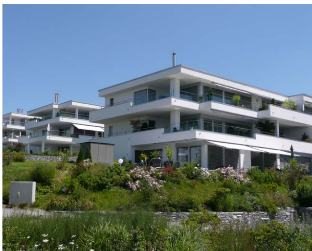
Trattamento dell'acqua piovana a Ostermundigen Fonte: Michael Burkhardt
