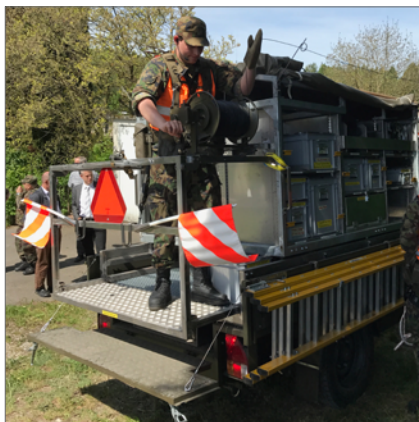
Costruzione di linee
