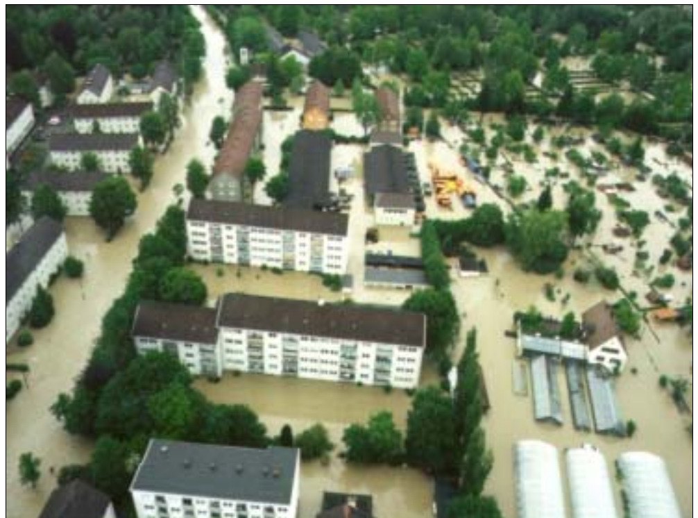
Fig. 2: L'exemple de la Rotachstrasse à Kempten – dans une région bavaroise également submergée par les crues du printemps 1999 – laisse pressentir l'énergie déployée par la nature pour reconquérir sa place. Par bonheur, l'environnement n'a pas subi de graves dommages sous la forme de pollution des eaux souterraines.
