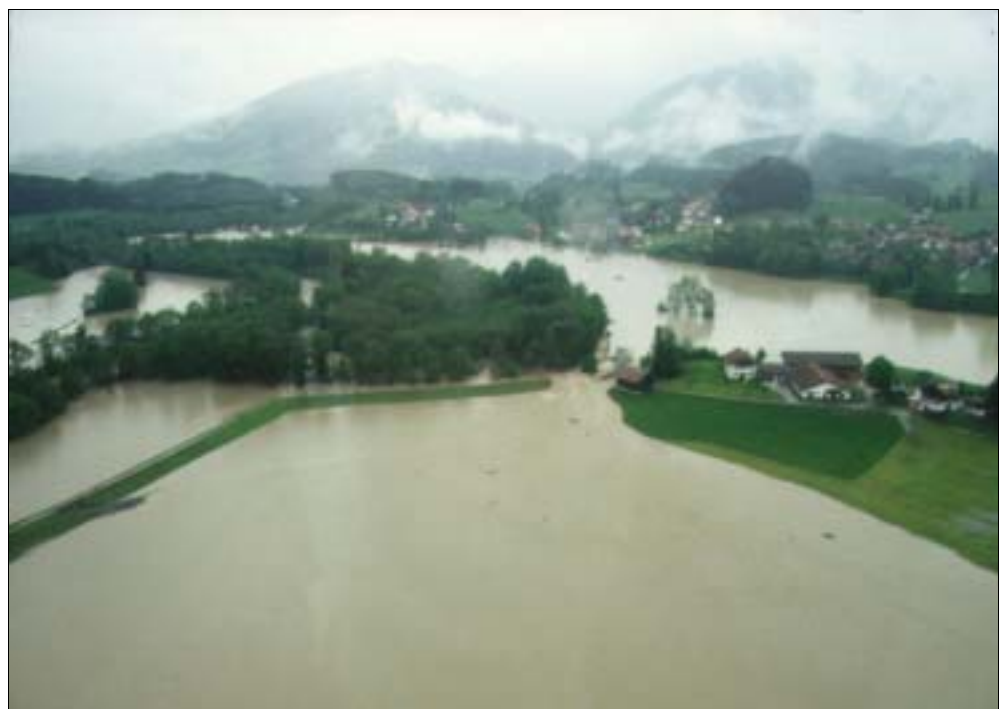
Fig. 3: Rupture de digue à Flecken, le 22.05.1999. L'exiguïté du territoire, l'augmentation de la superficie des sols imperméabilisés, des précipitations extrêmes et une exploitation du sol en dépit des risques naturels débouchent systématiquement sur d'importants dégâts ma- tériels, voire des victimes humaines, lorsqu'une rivière ou un torrent se ménage de la place.
