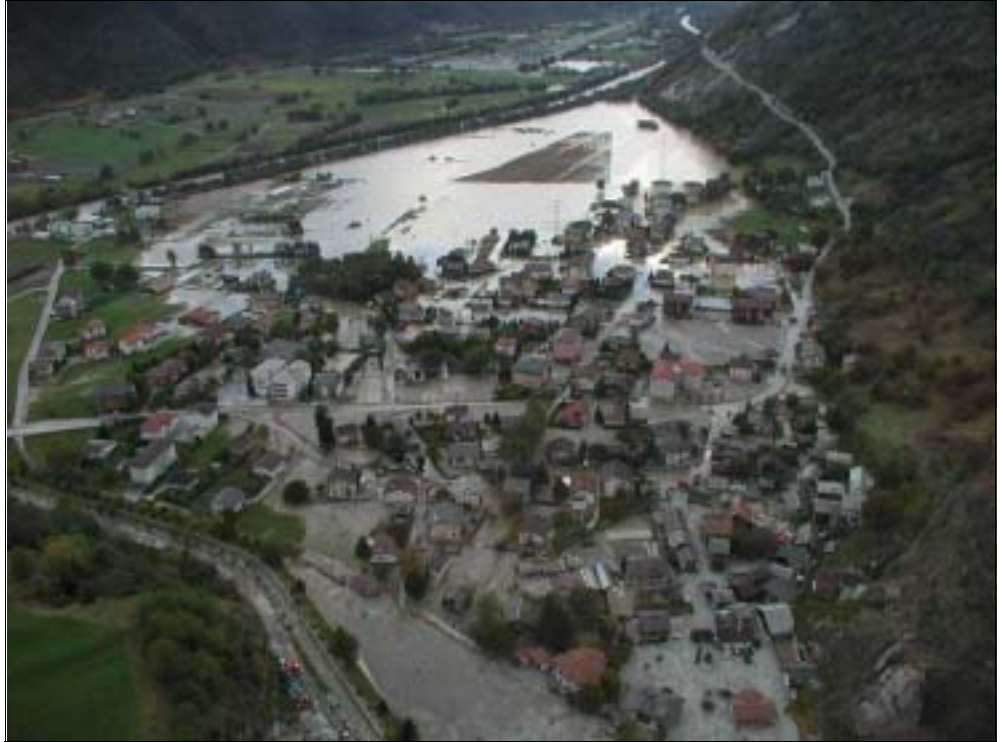
Abbildung 8: Baltschieder im Kanton Wallis Oktober 2000. Dort wo der Wildbach zuwenig Raum hat und die notwendige Rück- haltekapazität fehlt, holt sich der Wildbach den von ihm benötigten Platz zurück. Trotz hohen Sachschäden an den Wohnhäusern waren glücklicherweise keine- Todesopfer zu beklagen.
