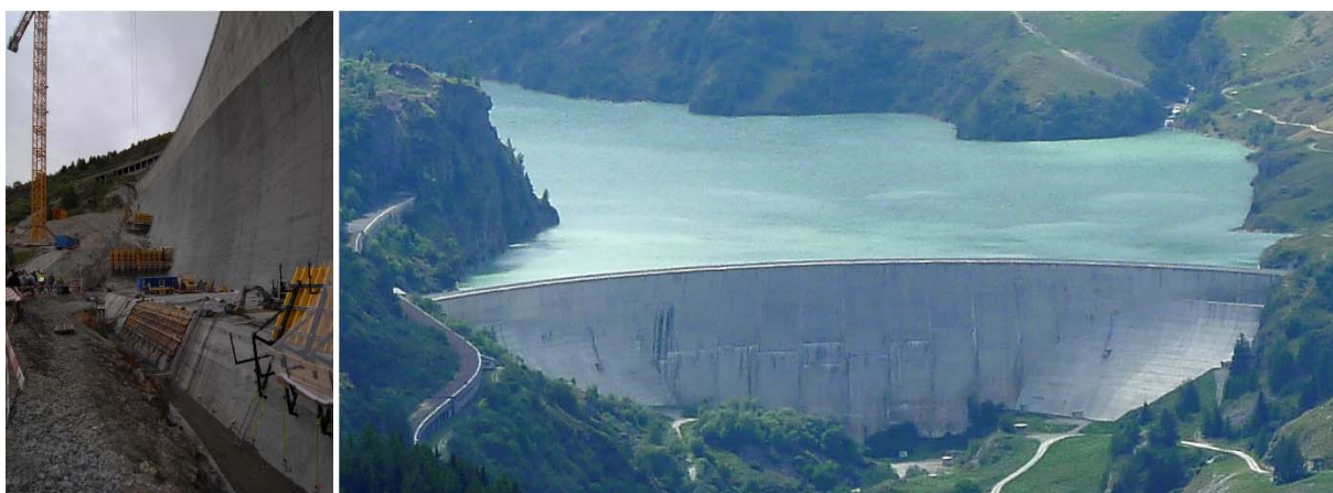
Abbildung 12: Erdbebensicherheitsmassnahmen für die Bogenstaumauer Les Toules im Wallis durch massiven Beton-Stützkörper auf der linken Talseite (links) und mit den fertiggestellten Stützkörpern auf beiden Talseiten (rechts). Bilder Thomas Wenk, Zürich.
