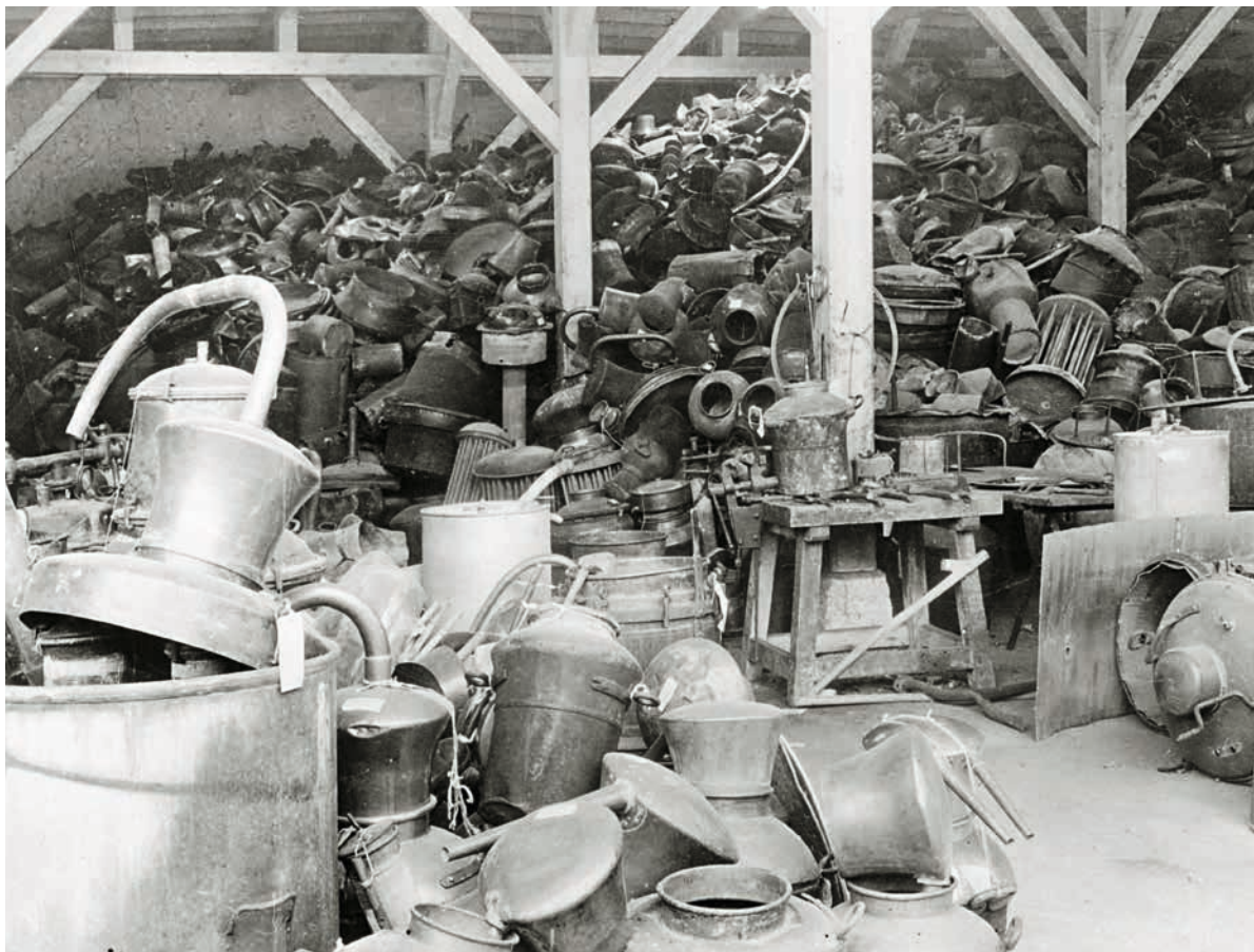
3.3.3 Grazie alla nuova legislazione sull'alcol, la Regia poté acquistare e smaltire le installazioni dei distillatori domestici.
