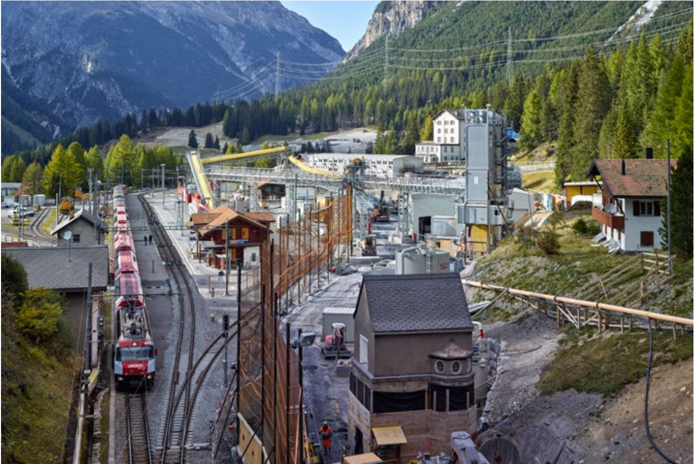
Der Albulatunnel II ist im Bau. Er wird den bestehenden Tunnel aus dem Jahr 1903 ersetzen und die Sicherheit verbessern.
