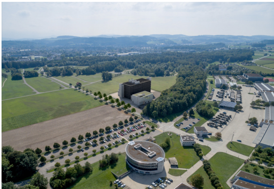
Visualizzazione dell'edificio d'esercizio con un modulo del centro di calcolo
