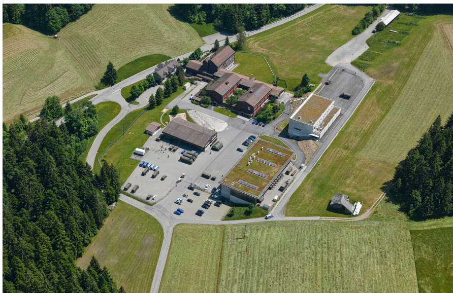
Veduta aerea della piazza d'armi di Jassbach
