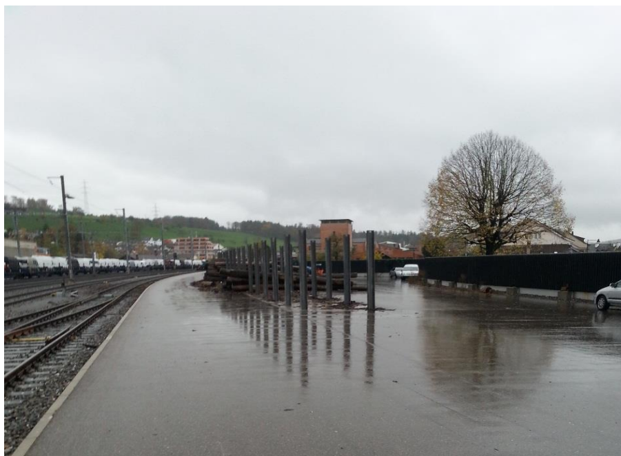
Impianto di Lausen (BL)
