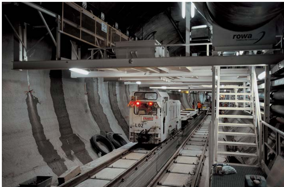
Cantiere galleria di base del San Gottardo
