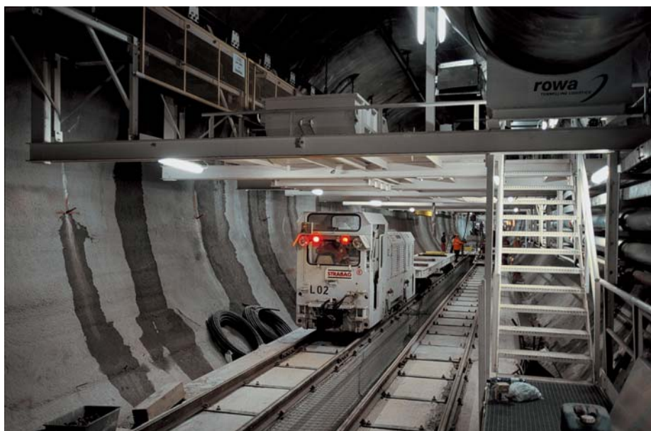
Chantier tunnel de base du St-Gothard
