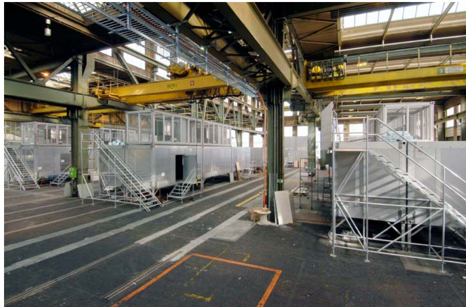
Montagehalle für Container Bahntechnik
