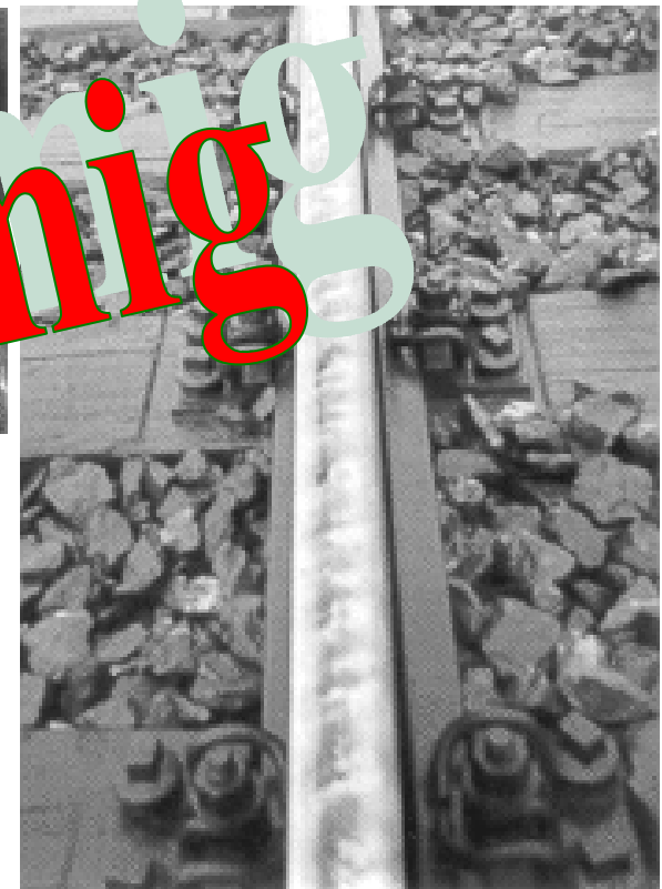
Rad und Schiene nach Beanspruchung („Verriffelungen“)
