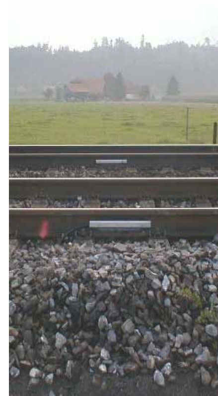
Misuratori della dilatazione dei binari (conta-assi)
