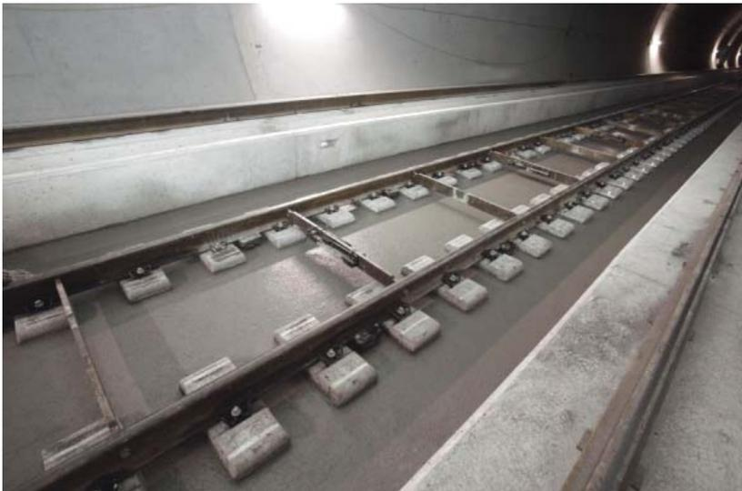
*Sopra: nel padiglione di montaggio a Raron vengono montate le campate dei binari (maschera per il montaggio dei binari) della lunghezza di 18 m ed in seguito portate in galleria. In mezzo: le campate dei binari vengono posate sulla platea della galleria, esattamente regolate ed in seguito cementate. Sotto: tratta di binari cementata.*
