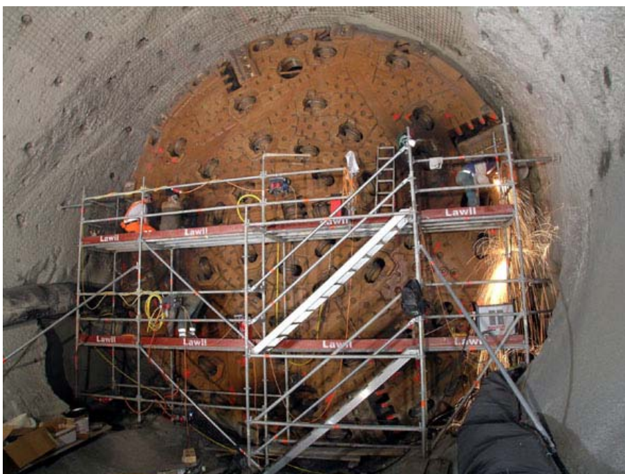
Amsteg: Révision du tunnelier
