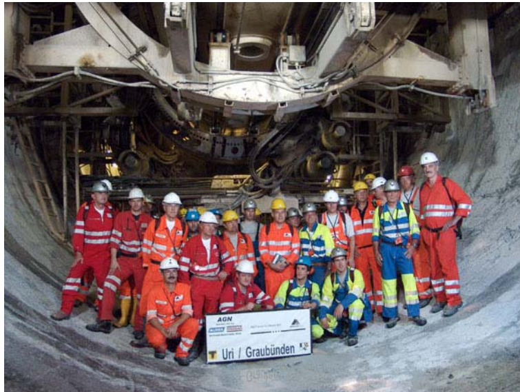
Amsteg: le tunnelier passe la frontière cantonale Uri – Grison
