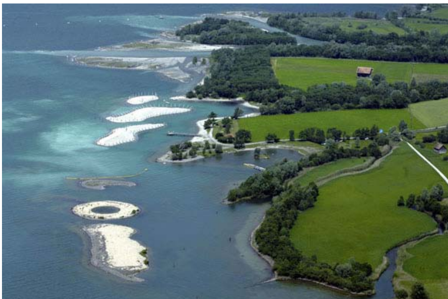
Lac d'Uri: Remblai en juin 2005
