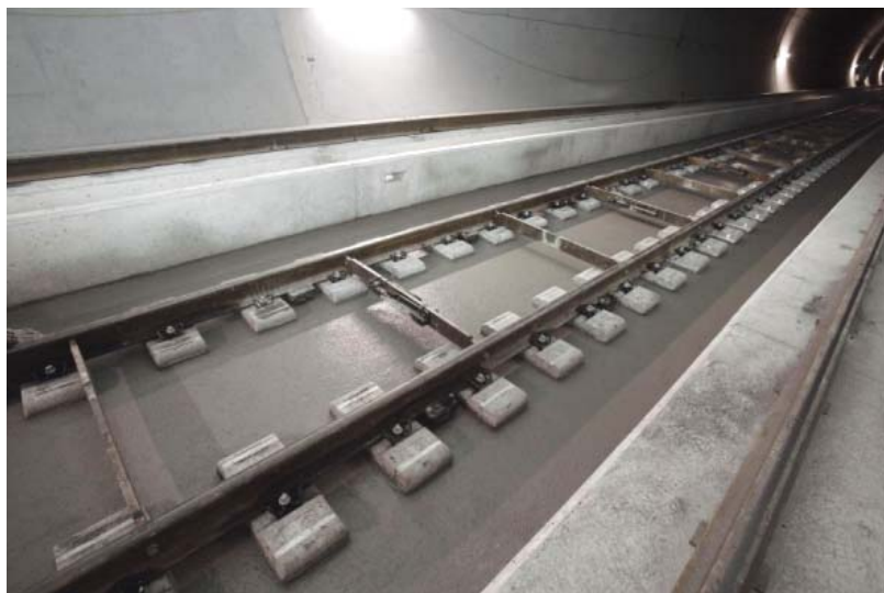
Haut: dans la halle de montage de Rarogne, on monte les éléments de voie préfabriqués de 18 m de longueur (matrices de montage) avant de les apporter dans le tunnel. Milieu: les éléments de voie préfabriqués sont posés sur le sol du tunnel, positionnés exactement puis scellés. Bas: tronçon bétonné terminé.
