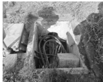
Erschliessungsschacht Strom
