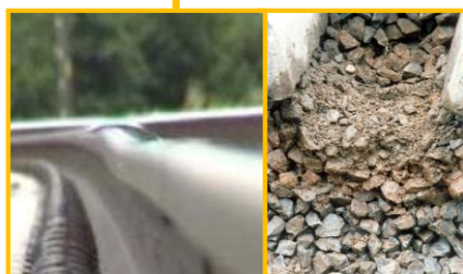
Degrado massicciata Spostamento rotaie
