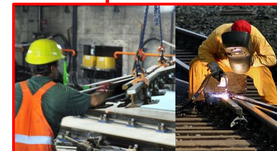
Sostituzione/manutenzione parti di scambi
