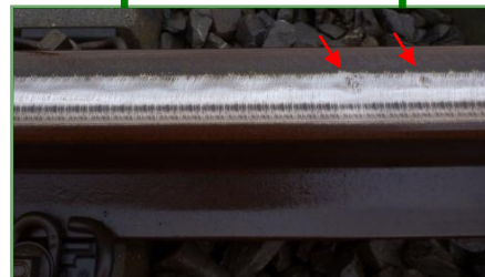
Usure du rail «trçons rectilignes»
