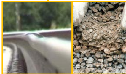
Dégradation du ballast Perte de l'assiette de la voie
