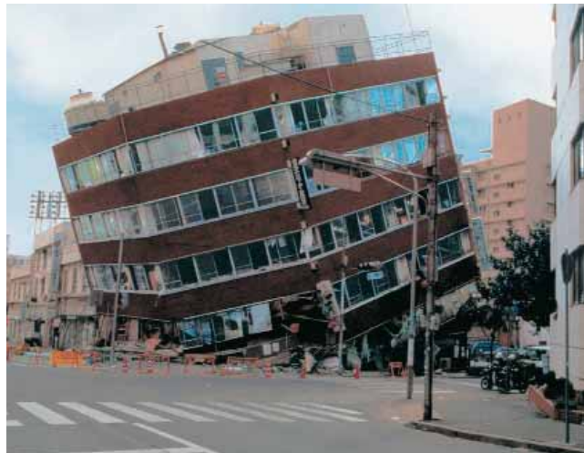
Bâtiment équipé d'un contreventement dissymétrique (Kobe, Japon, 1995) [5]
