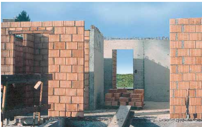
Immeuble en maçonnerie, renforcé par des parois en béton armé [5]
