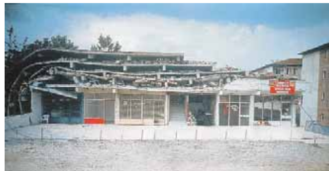
Bâtiment avec des étages flexibles (Izmit, Turquie, 1999, tiré de [5])
