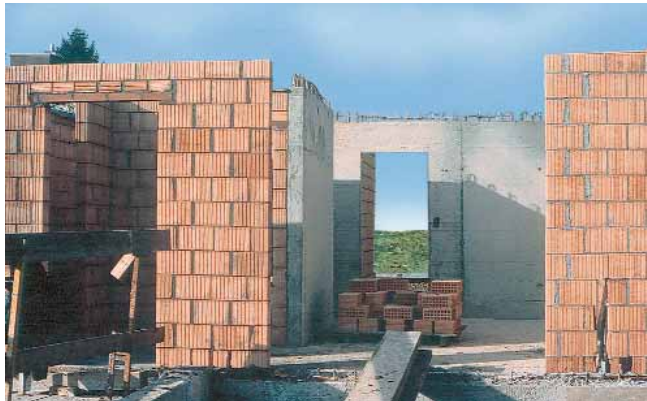
Wohnblock als Mauerwerksbau, ausgesteift mit Stahlbetonwänden [5]
