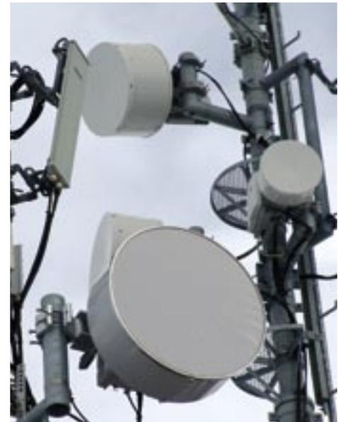
Diese Richtfunkantennen auf dem Jakobshorn GR verbinden Mobilfunk-Basisstationen über relativ kurze Distanzen mit einer Telefonzentrale.
