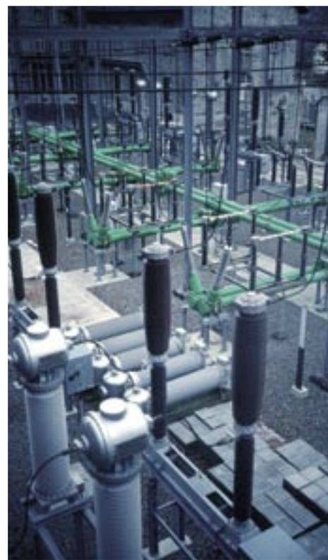
Neben Hochspannungsleitungen erzeugen auch Unterwerke innerhalb der Umzäunung relativ starke Magnetfelder.
