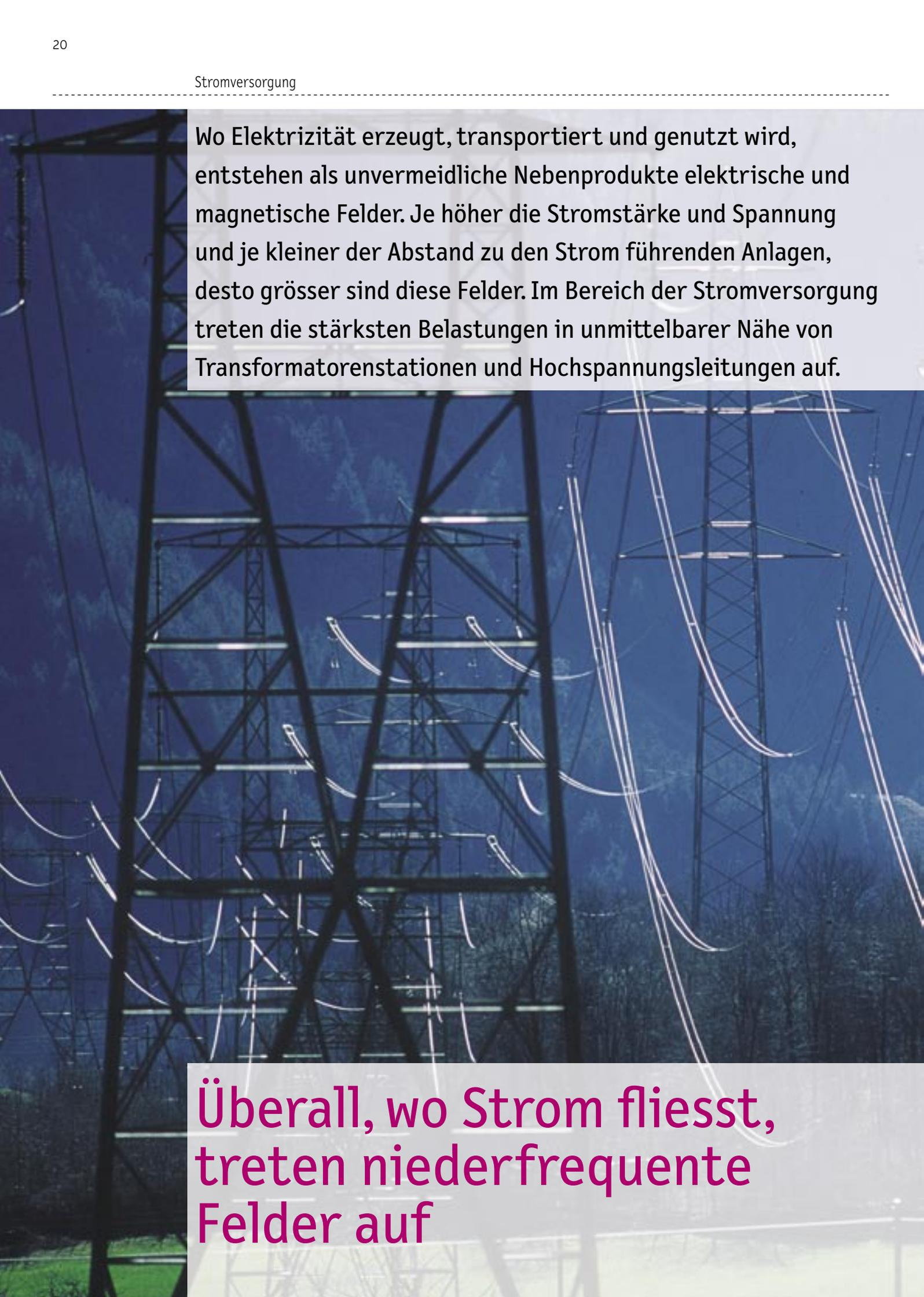
Wo Elektrizität erzeugt, transportiert und genutzt wird, entstehen als unvermeidliche Nebenprodukte elektrische und magnetische Felder. Je höher die Stromstärke und Spannung und je kleiner der Abstand zu den Strom führenden Anlagen, desto grösser sind diese Felder. Im Bereich der Stromversorgung treten die stärksten Belastungen in unmittelbarer Nähe von Transformatorenstationen und Hochspannungsleitungen auf.
