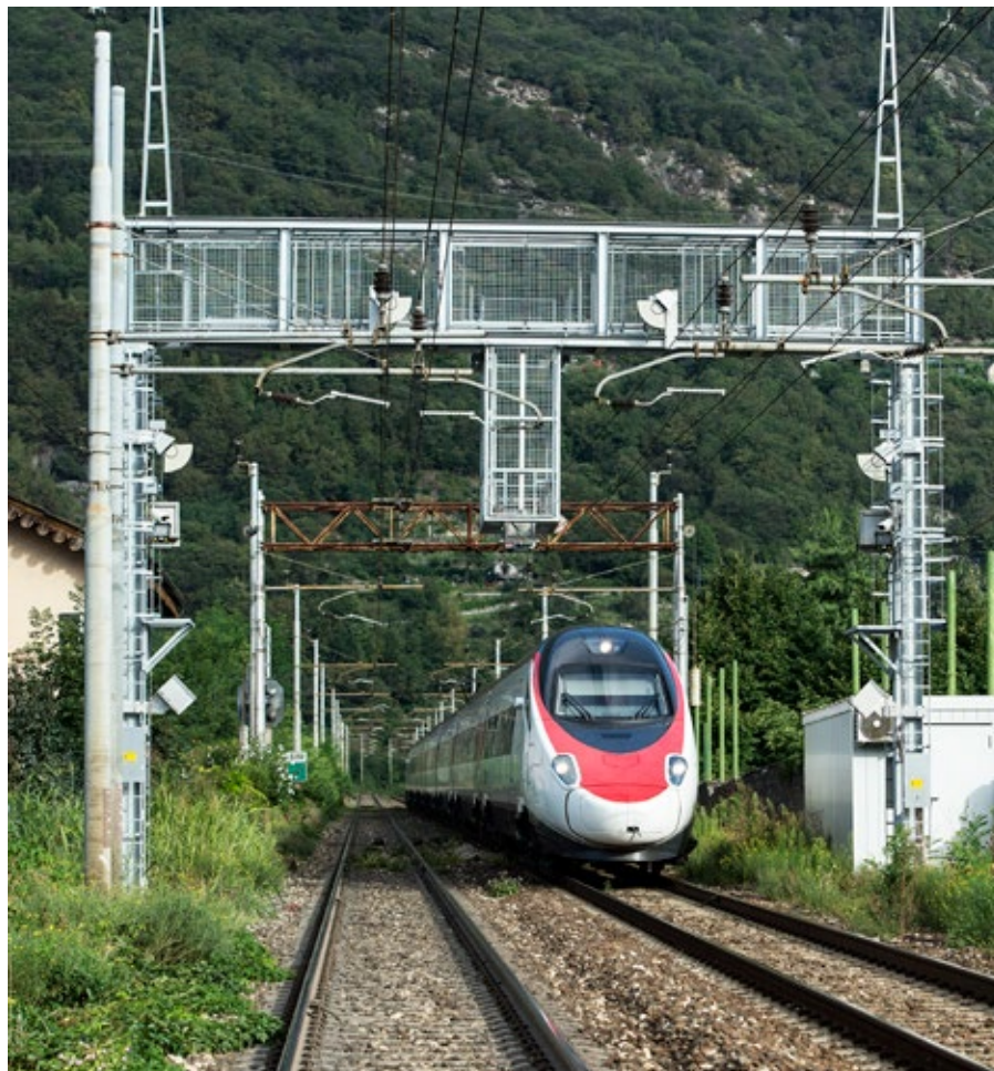
Eine neue Profil- und Antennenortungsanlage in Domodossola erkennt schadhafte Züge.
