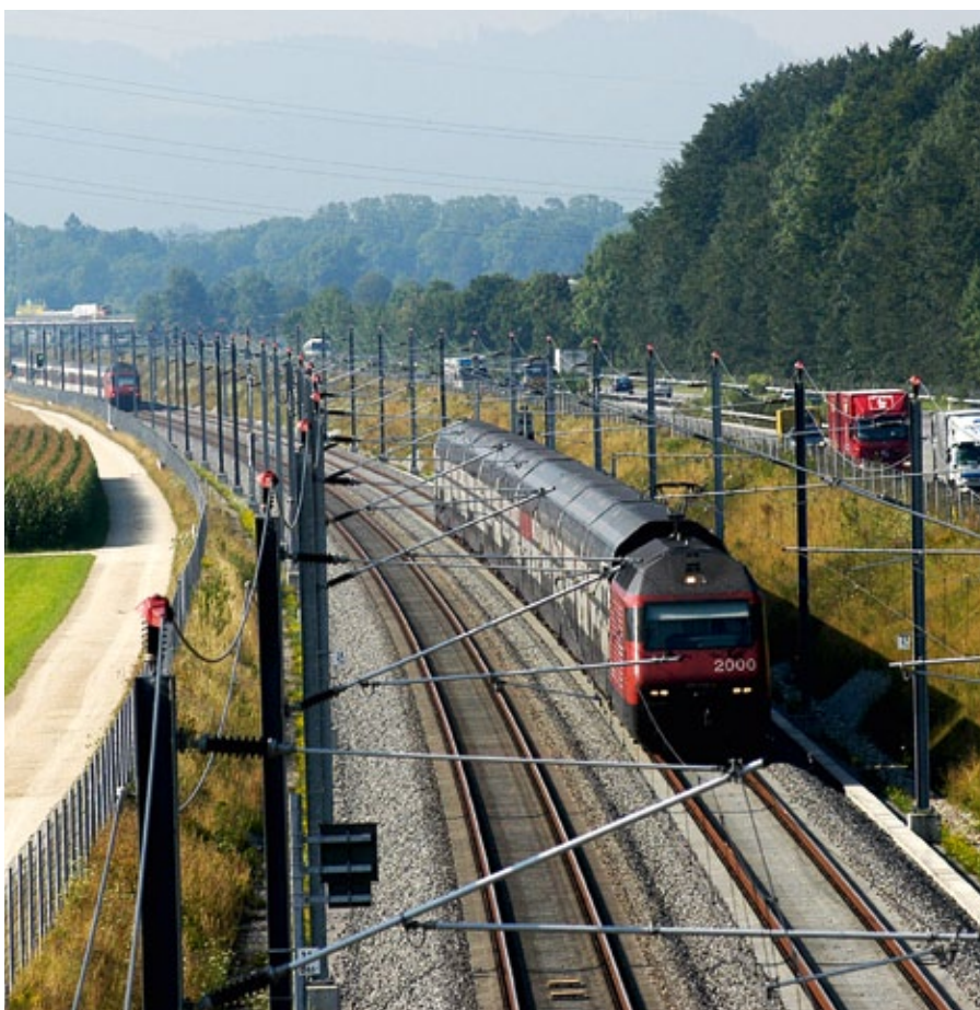
L'ETCS Level 2 est déjà utilisé entre Mattstetten et Rothrist (image).
