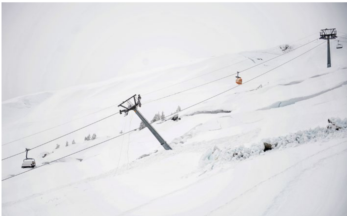
Le poids de la neige a abattu un pylône de télésiège à Lungern-Schönbüel.
