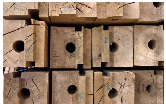
▼ Ferienheim Büntenhard SH. Eichenbalken mit Kernbohrung. Architekten: Bernath und Widmer, Zürich, Ingenieur: Hermann Blumer. Centre de vacances de Büntenhardt (SH). Poutres en chêne dont le cœur a été évidé. Architectes: Bernath und Widmer, Zurich. Ingénieur: Hermann Blumer.
