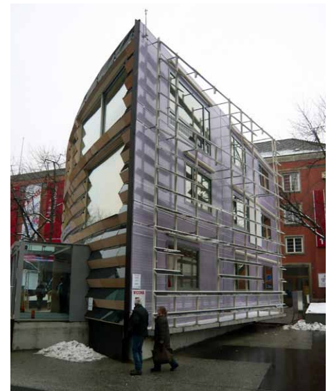
▲ Woodstock, Prototyp aus 45 m 3 Buchenholz für Swissbau 2010 Basel. Architektur: Tobler + Knobel, Basel, Ingenieur: Hermann Blumer. Woodstock, prototype en bois de hêtre de 45 m 3 pour Swissbau 2010 à Bâle. Architectes: Tobler + Knobel, Bâle. Ingénieur: Hermann Blumer.
