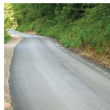
Cette route de montagne bitumée n'est plus un chemin de randonnée approprié.
