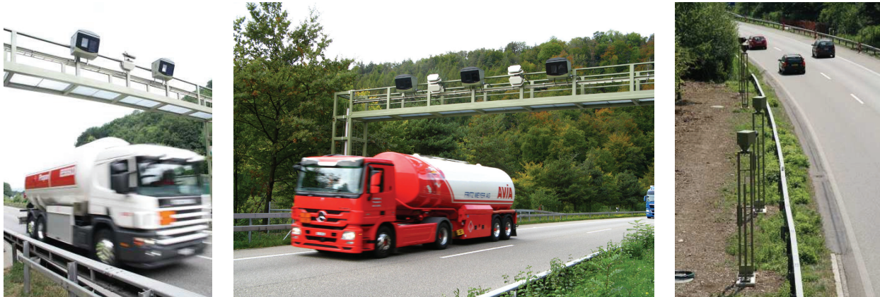
Abbildung 42: AGK Eingangsportal (links), AGK Ausgangsportal (Mitte) und anschliessendes Fahrererkennungssystem für die Beweisbilderfassung (rechts), Pilotabschnitt A2 Arisdorftunnel
