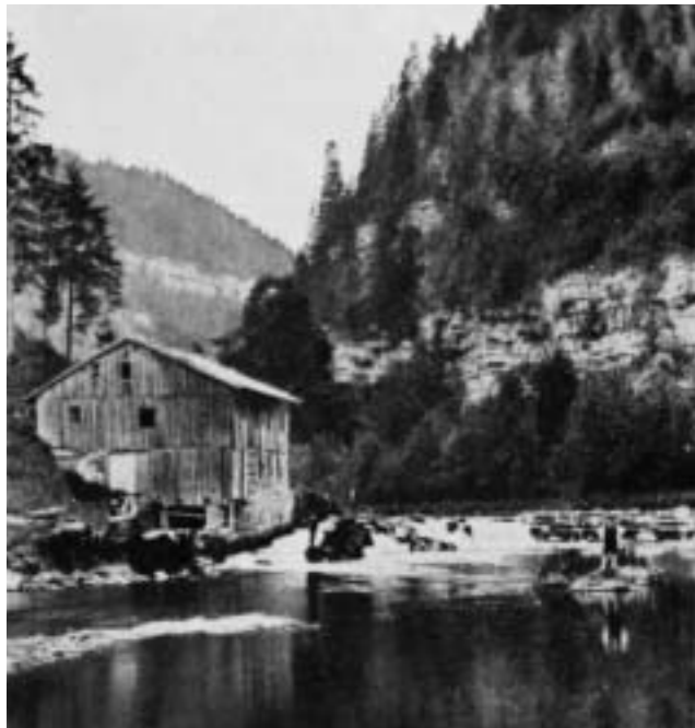
Le Moulin Delachaux abandonné vers 1870
