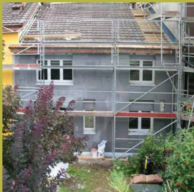
Le lotissement de 1983 pendant les travaux d'assainissement
