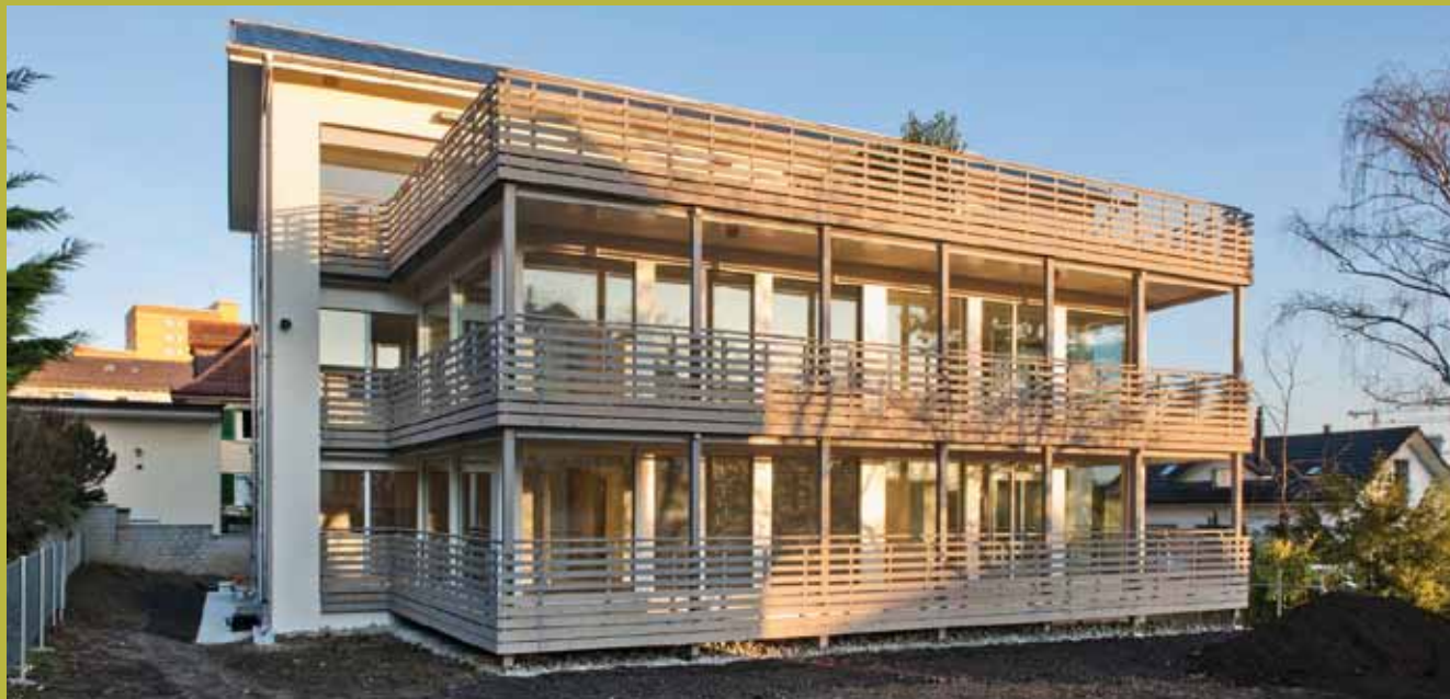
La maison à énergie zéro à Zurich-Oerlikon après assainissement
