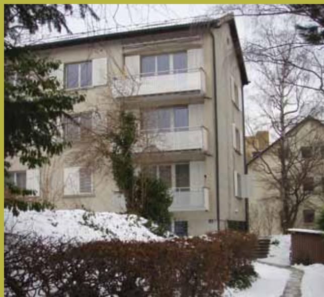
Une habitation ordinaire pour six familles avant assainissement
