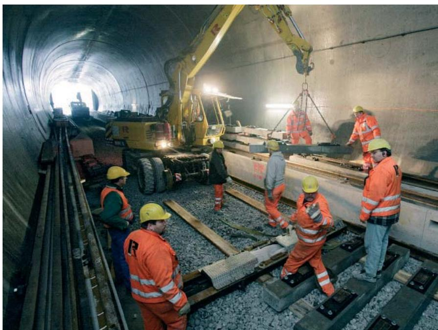
Pose des traverses au portail nord du tunnel de base du Loetschberg.
