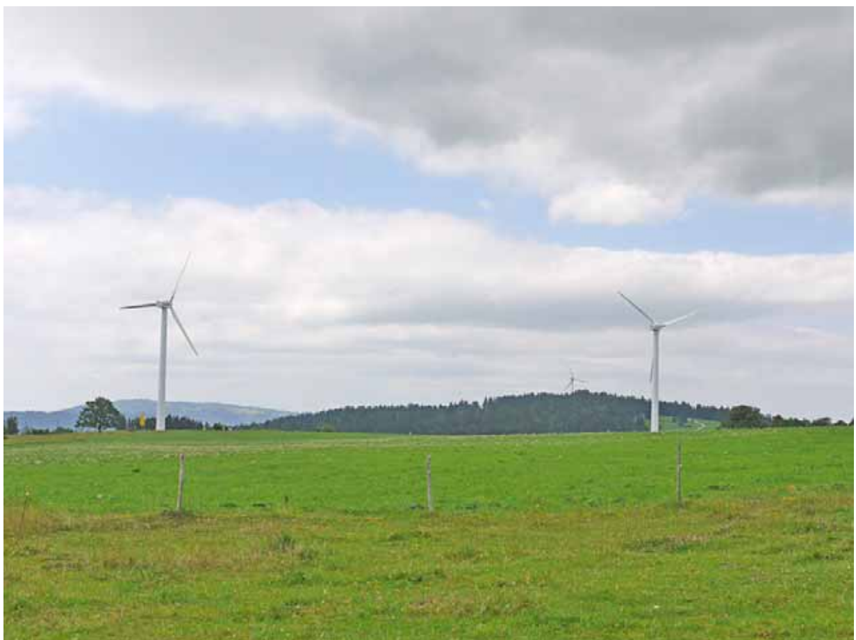
Centrale éolienne Mont-Crosin – Mont-Soleil (Jura)
