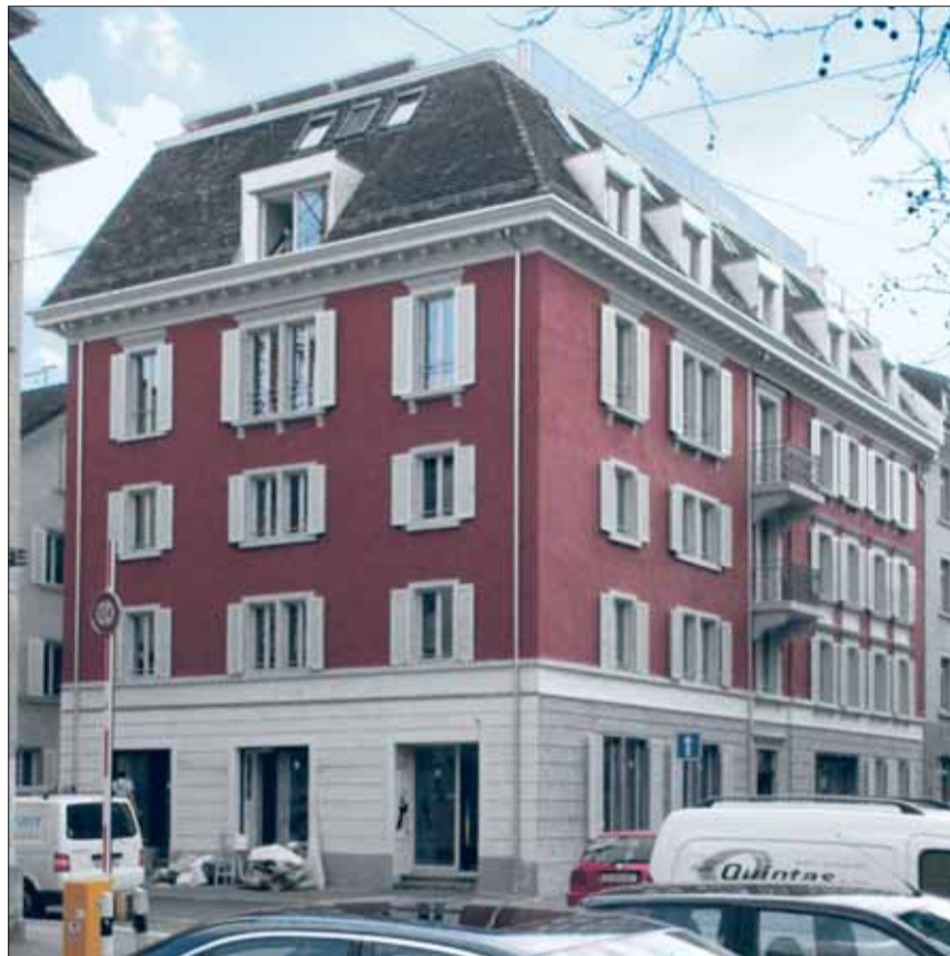
Il aura fallu six mois à peine pour assainir intégralement l'immeuble collectif de la Magnusstrasse 28 à Zurich – avec aménagement d'un nouvel étage sous le toit à partir d'éléments préfabriqués.
