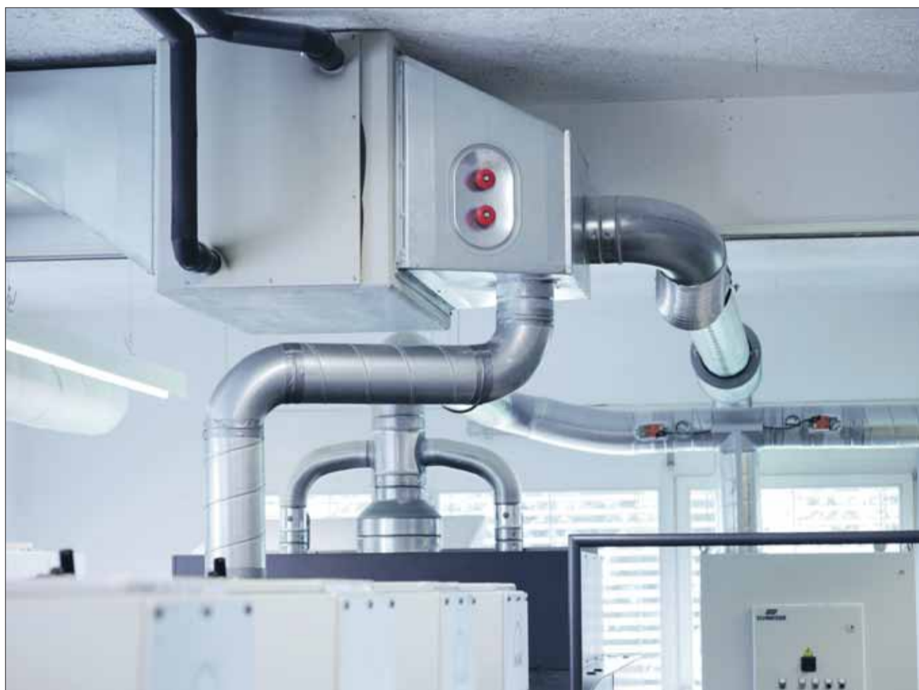
L'échangeur thermique au-dessus du rouleau ralentisseur de la machine R 505 LV prélève l'énergie véhiculée par l'air sortant du processus de séchage et de l'aspiration de poudre et la met à disposition de l'air entrant vers le monobloc pour chauffer ou rafraîchir la salle d'impression. L'opération se déroule sans gaspillage d'énergie.
